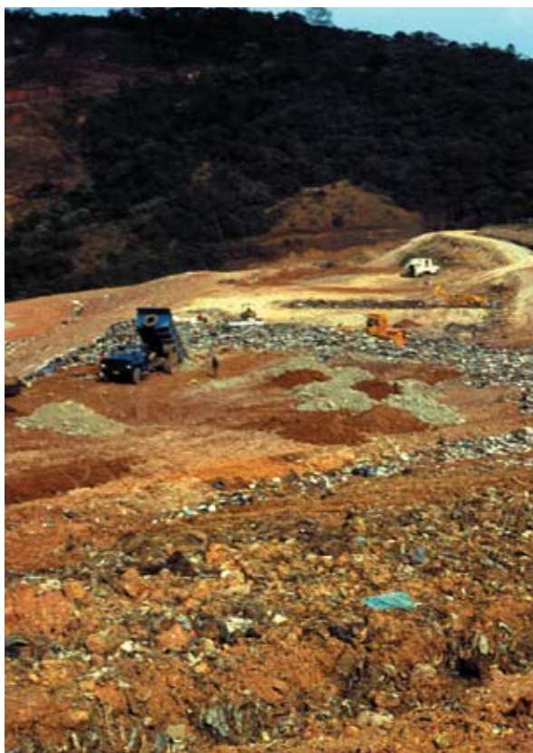
Aterro sanitário. Note que o lixo é enterrado com camadas de terra.
